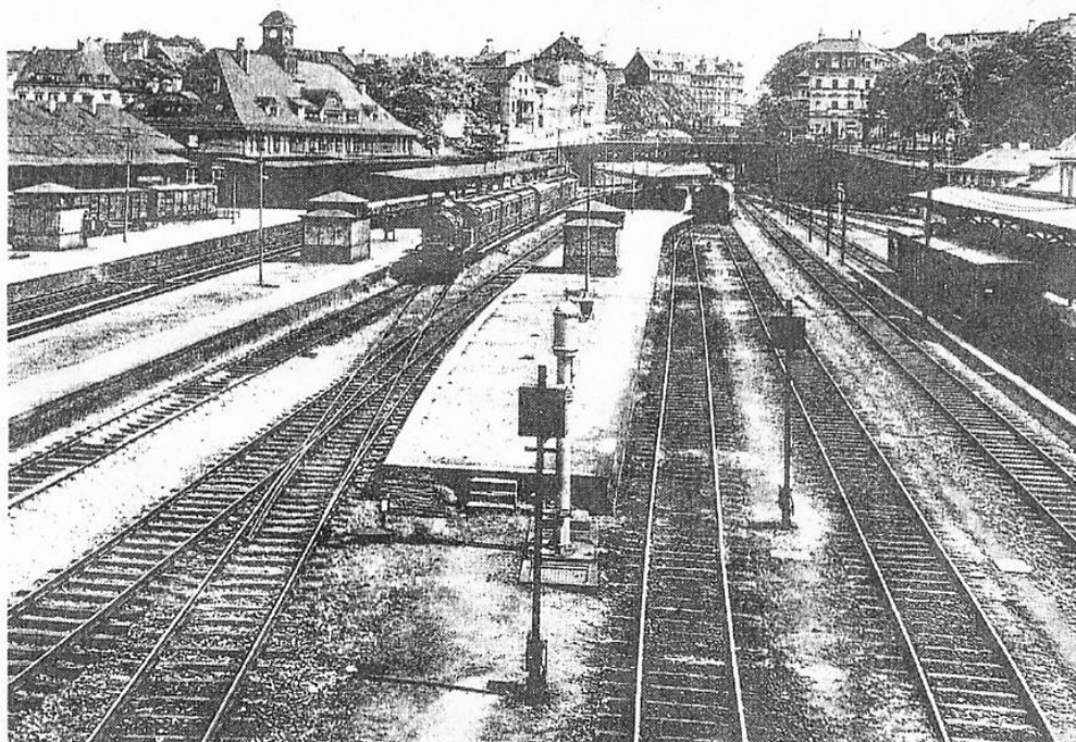
Der Bahnhof Steinbeck in den 1930er Jahren. Von hier fuhr am 9. November 1941 der Zug mit den Deportierten ab.
