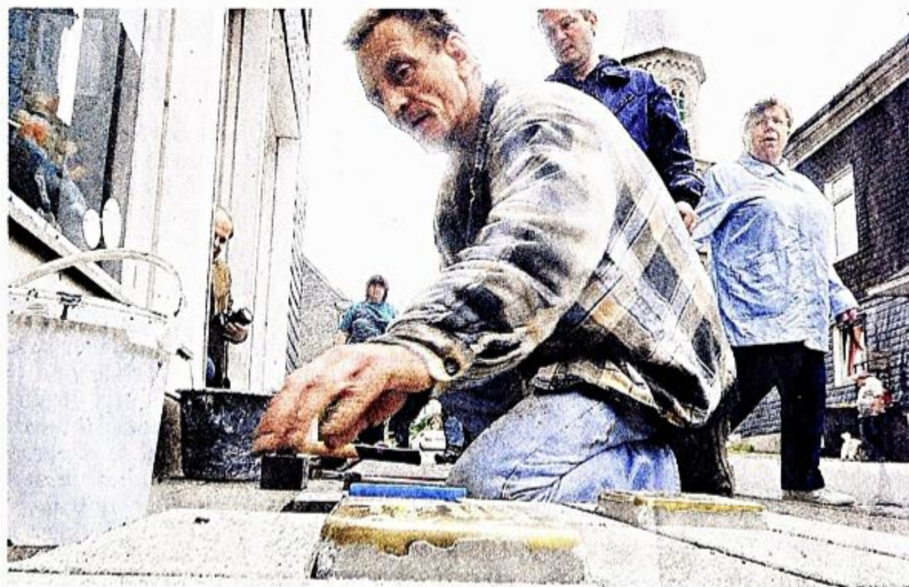
Vor dem Haus an der Elias-Eller-Straße wurden zwei Stolpersteine verlegt.
